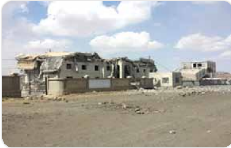
صورة دمار كلية صعدة التابعة لجامعة عمران نتيجة قصف طيران تحالف دول العدوان
