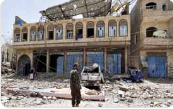
آثار دمار المنازل المجاورة لحصن كوكبان التاريخي نتيجة قصف طيران تحالف دول العدوان
